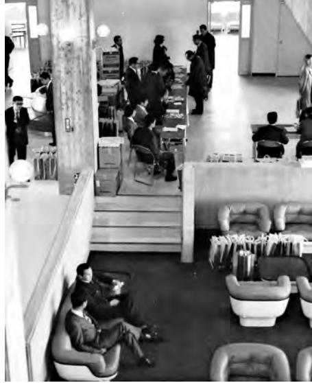
1階のロビーの様子。ラウンジチェアが置かれ人々が談笑する場となっている
