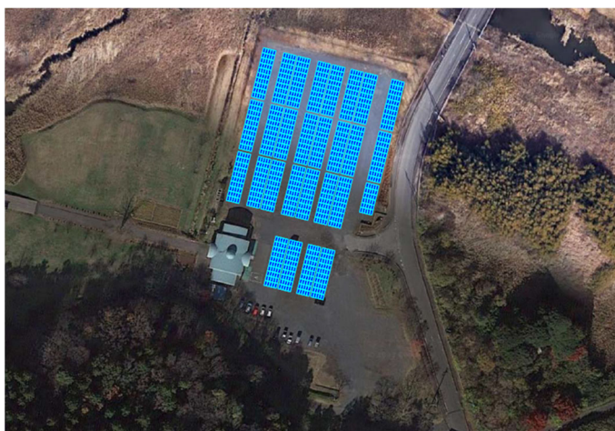
涸沼自然公園の太陽光発電システム導入想定箇所
