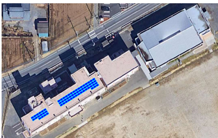
大戸小学校の太陽光発電システム導入想定箇所
