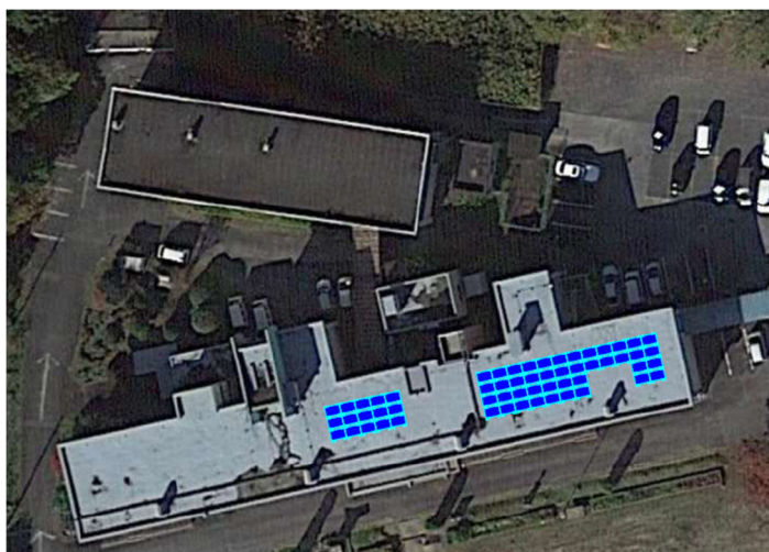
駒場庁舎の太陽光発電システム導入想定箇所
