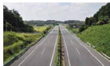
北関東自動車道
