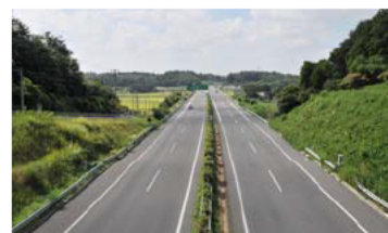
北関東自動車道
