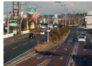
国道 6 号沿道部(長岡)
