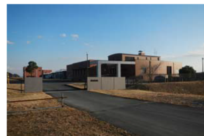
茨城町浄化センター
