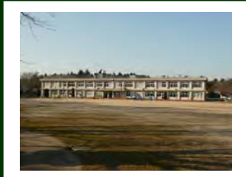
校舎 S51年建築(未改修)
