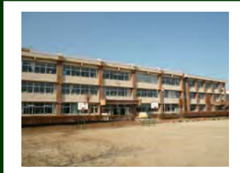
校舎 S56年建築(未改修)
