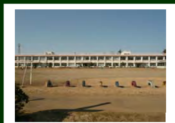
校舎 S45年建築(未改修)
