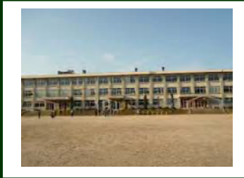
校舎 S48年建築(未改修)
