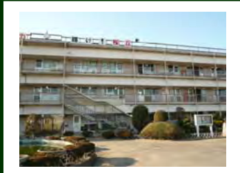
校舎 S36年建築(未改修)
