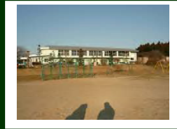
屋内運動場 S49年建築(改修済)
