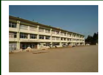
校舎 S45年建築(未改修)
