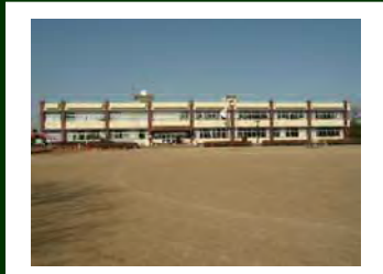
校舎 S53年建築(未改修)
