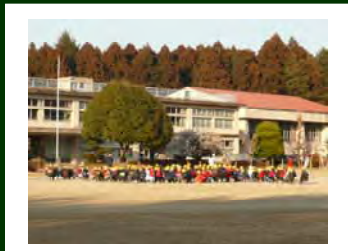
校舎 S45年建築(未改修)
