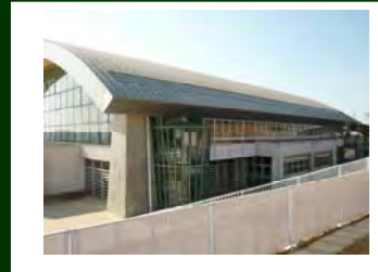
屋内運動場 H5年建築
