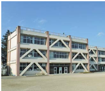
内外装などが改修される 長岡小学校校舎
