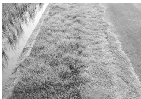
②除草剤散布前の路肩 （芝等が根を張り崩れにくい）
