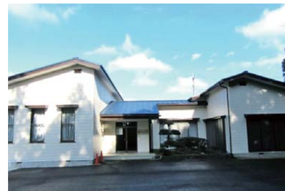
修繕を終えた五里峰集落センター
