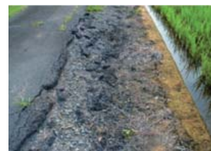
除草剤を使用している路肩
