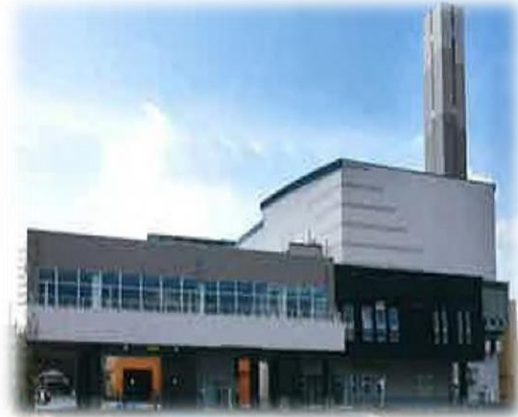
【出典：霞台厚生施設組合】 霞台クリーンセンターみらい
