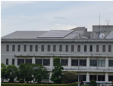
茨城町役場屋上の太陽光発電設備
