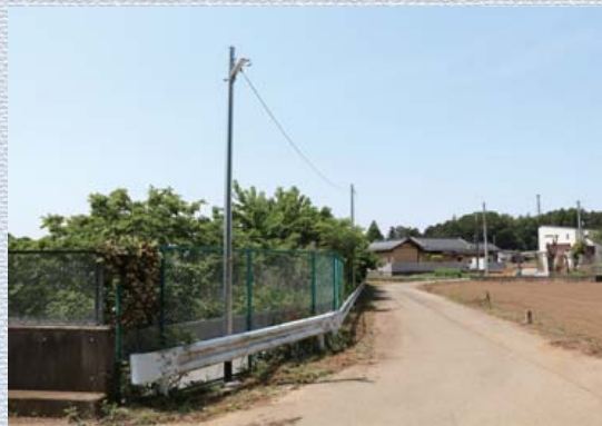
防犯灯の設置
