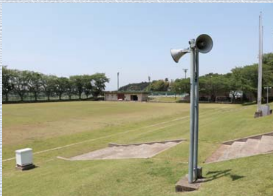
運動公園屋外スピーカーの改修
