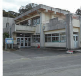
改修工事前の長岡幼稚園
