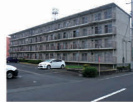
改修工事前の矢頭団地B棟
