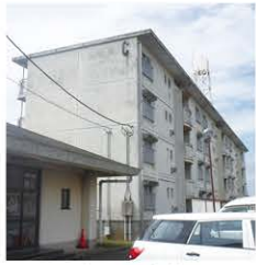
改修工事前 矢頭団地C棟(奥)
