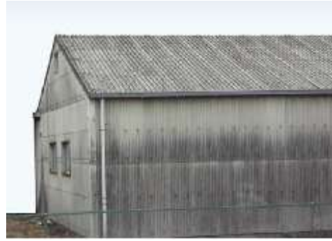
石綿含有スレート波板（屋根・外壁）
