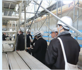
通路等の建設状況を確認する様子
